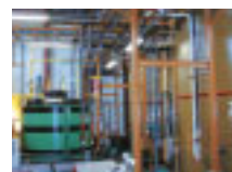
廃水処理施設
