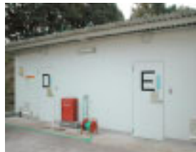
PCB保管倉庫
