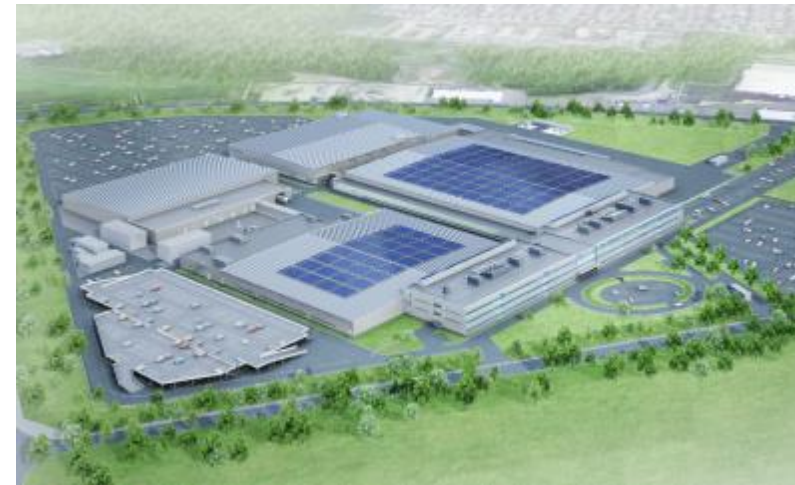
東京エレクトロン宮城 新開発棟・物流棟
