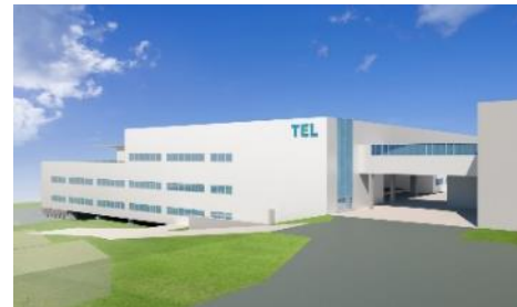
山梨工場：建設費約130億円 (2019年1月着工、2020年4月竣工予定)
