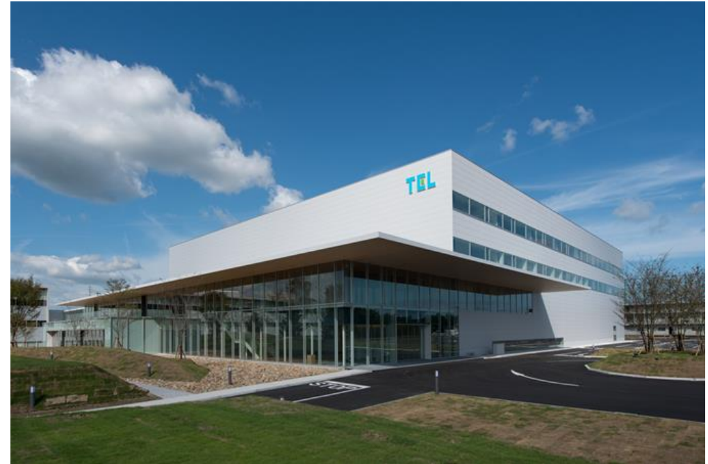
東京エレクトロン宮城 宮城技術革新センター
