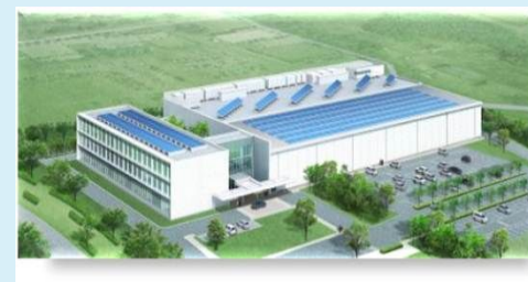
テクノロジーセンターつくば
