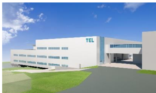
山梨県富士吉田市：建設費約130億円 (2019年1月着工、2020年4月竣工予定)
