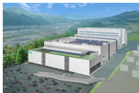
山梨県富士崎市：建設費約130億円 (2019年2月着工、2020年4月竣工予定)
