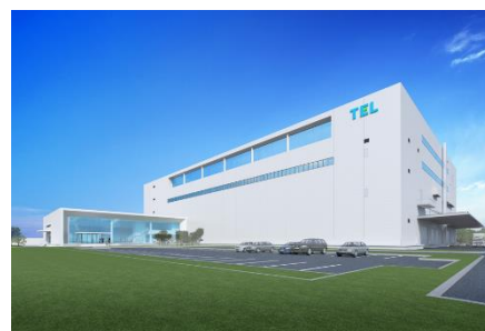
岩手県奥州市：建設費約130億円 (2018年10月着工、2019年10月竣工予定)
