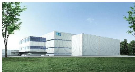
宮城県黒川郡：建設費約470億円 (2025年春 竣工予定)
