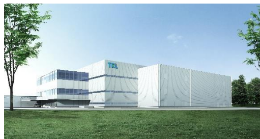
宮城県大和町：建設費約470億円 (2025年春 竣工予定)
