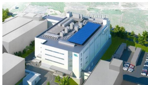
山梨県斐崎市 2023年7月 竣工
