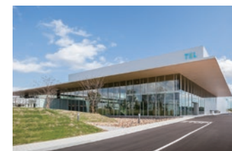
東京エレクトロン宮城宮城技術革新センター 2021年10月 稼働開始
