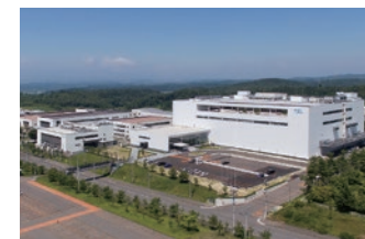
東京エレクトロンテクノロジーソリューションズ東北事業所 生産棟 2020年7月 稼働開始
