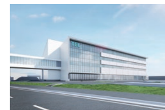
東京エレクトロン九州 新開発棟 (2025年夏竣工予定)
