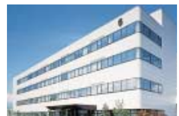
山梨県韮崎市にある新プロセステクノロジーセンター。半導体メーカーの300ミリウェーハへの移行を強力にサポートする最先端施設。
