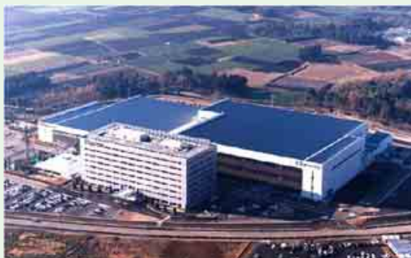
東京エレクトロン九州(株) 合志事業所
