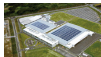
東京エレクトロン宮城株式会社
