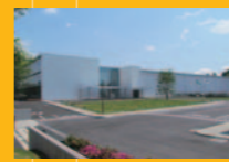
テクノロジーセンターつくば
