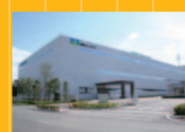
東京エレクトロン九州新生産棟完成
