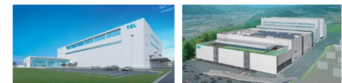
東京エレクトロンテクノロジーソリューションズ 新生産棟 (左: 東北事業所, 右: 藤井事業所)
